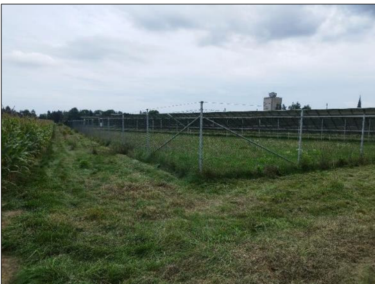
Blick von Nordwesten nach Südosten auf die südlich angrenzende Bestandsanlage „Straßkirchen Nord“
