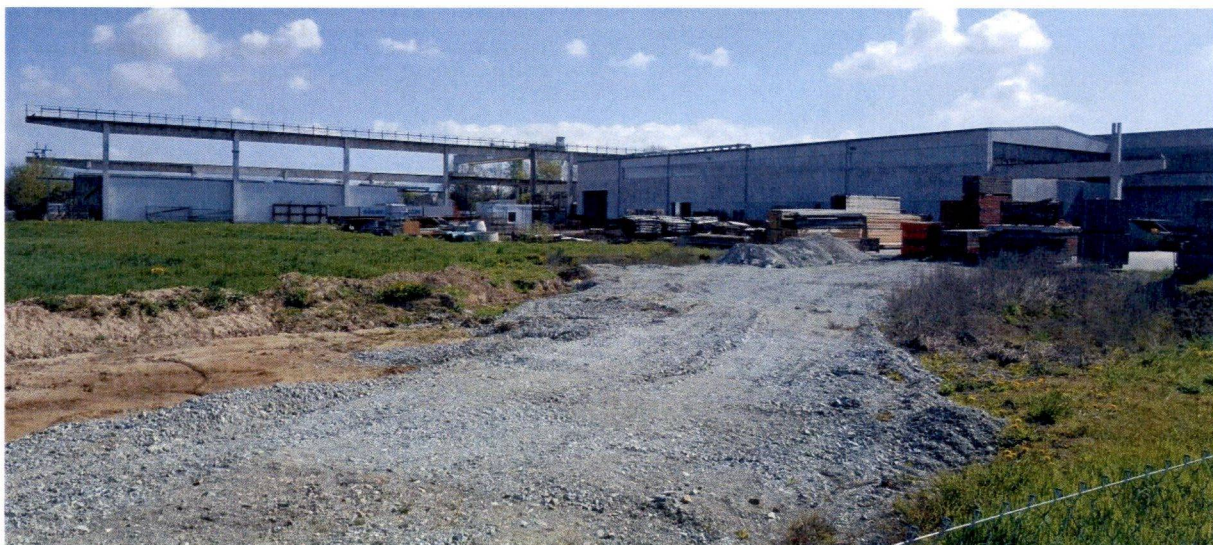
Abb. 9: geplante Erweiterungsfläche, Blick von Westen Richtung Nordosten, Foto Jocham + Kellhuber
