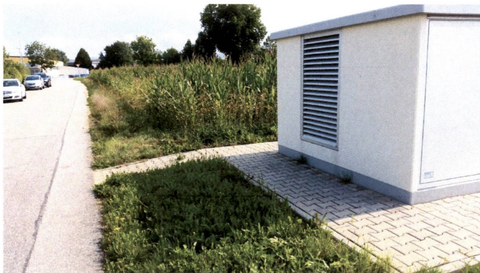
Blick auf den Geltungsbereich (Ackerfläche) mit angrenzender Erschließungsstraße (Ohmstraße), Richtung Norden
