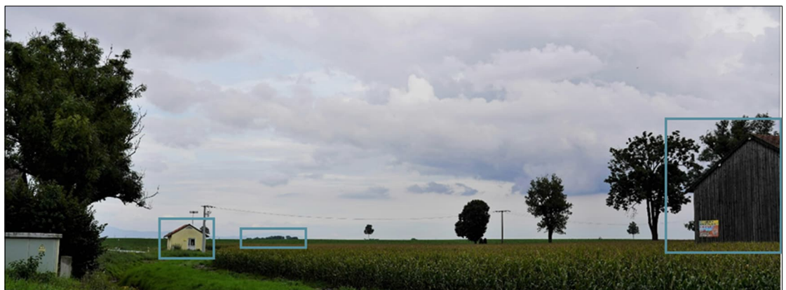
Abbildung 61. Blick Richtung Plangebiet: Verdeckung der Sichtachsen durch örtliche Gegebenheiten wie ein Häuschen, Waldstück und Scheune (blau).
